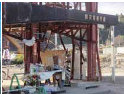
南三陸防災対策庁舎
