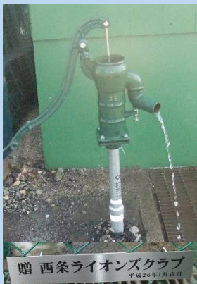
緊急避難指定場所(愛媛県立西条高等学校)へ手押しポンプを設置。緊急時に限らず、日頃から利用されることで、いざという時に安全に使用することができます。
