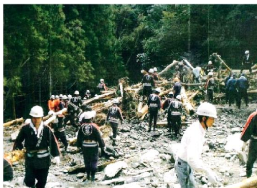
▲消防団による復旧作業 (提供: 西条市)
